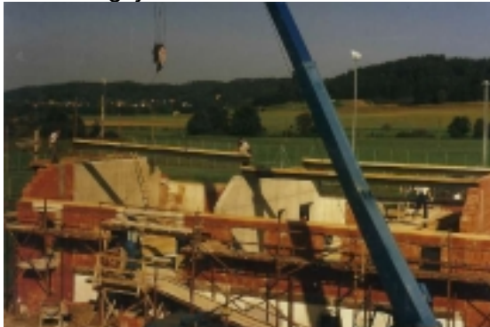
Ein Dachstuhl muss drauf: Alfred Glück und Georg Mengele
